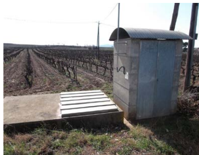
Imatge 3: Vista Exterior Pou La Granada
